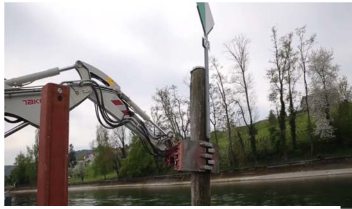
Abb. 10: Entfernung Wiffe Nr. 73 ( www.shn.ch ) 30
